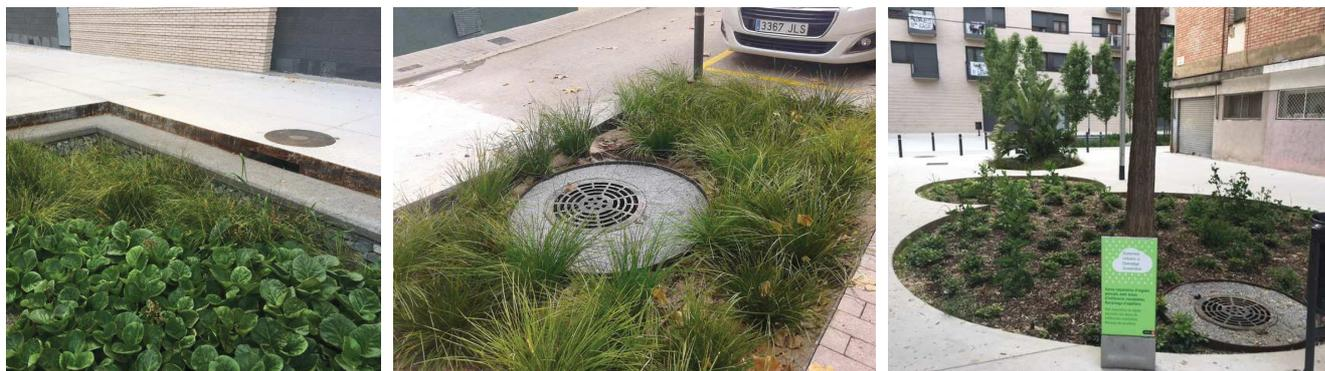
**Figura 6.** Detalle de sumidero en calzada conectado a los parterres inundables ajardinados.
